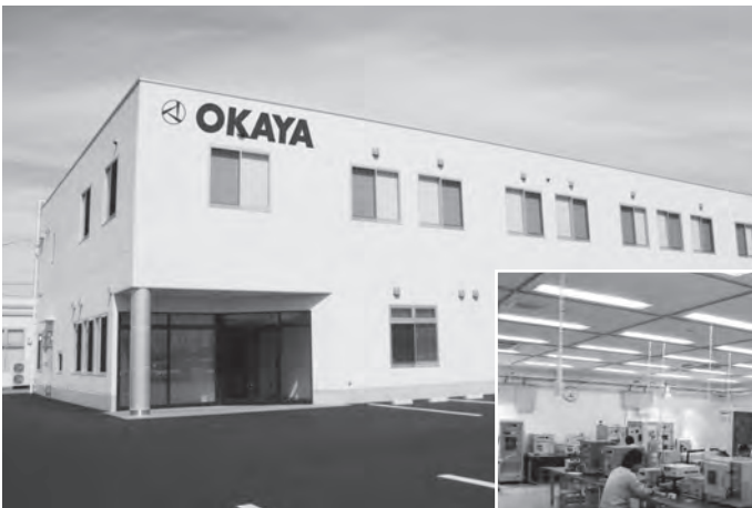
サージ試験棟(埼玉県行田市)
