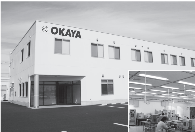
サージ試験棟(埼玉県行田市)
