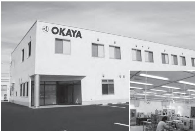
サージ試験棟(埼玉県行田市)
